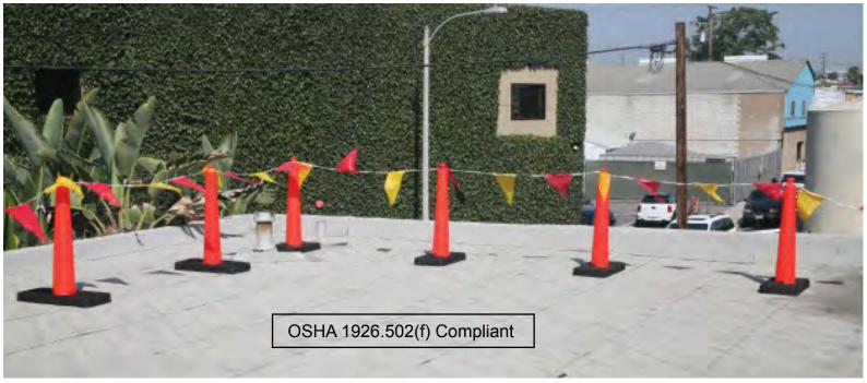
WARR N 39" MAX TIE OFF HEIGHT MINIMUM MINIMUM G-10 FEET FROM ROOF EDGE
