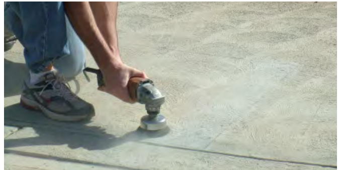
Grind surface. Pulir la superficie.
