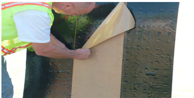
Remove paper backing. Remover el papel de respaldo.
