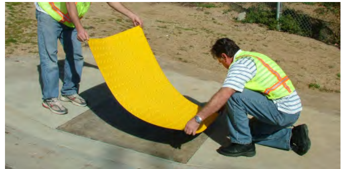
Set tile in place. Colocar el azulejo en el lugar.
