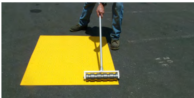
Apply pressure starting in the middle working out to the edges to ensure complete contact. Aplicar presion comenzando por el centro para el borde de afuera para asegurar contacto completo.
