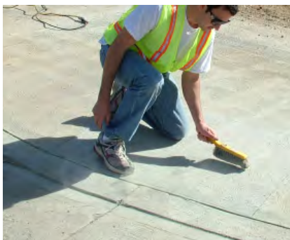
Clean with broom or blower. Barrer con escoba o soplador.
